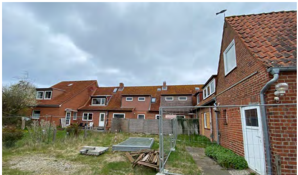
Blick auf die rückwärtigen Gebäude (Haus Waterkant) Foto: A + S, 2022
